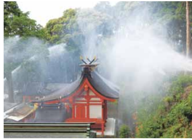
本館と摂社3棟に向けて放水銃7基が放水
